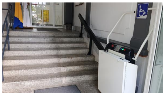
Slika 2. Podizna platforma nakon glavnog ulaza
