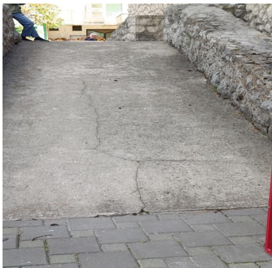
Slika 20. Pristup rampa do glavnog ulaza
