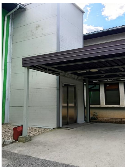
Slika 27. Lift za pristup gornjoj etaži
