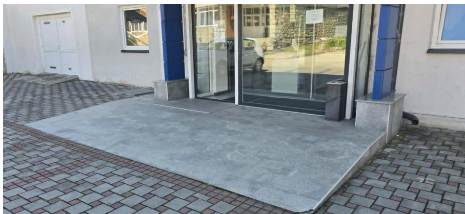
Slika 11. Pristupačan ulaz u objekat CIPS-a
