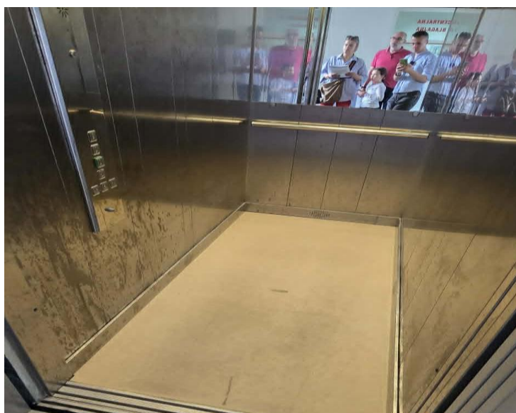
Slika 6. Pristupačan lift u objektu u Domu zdravlja Ključ
