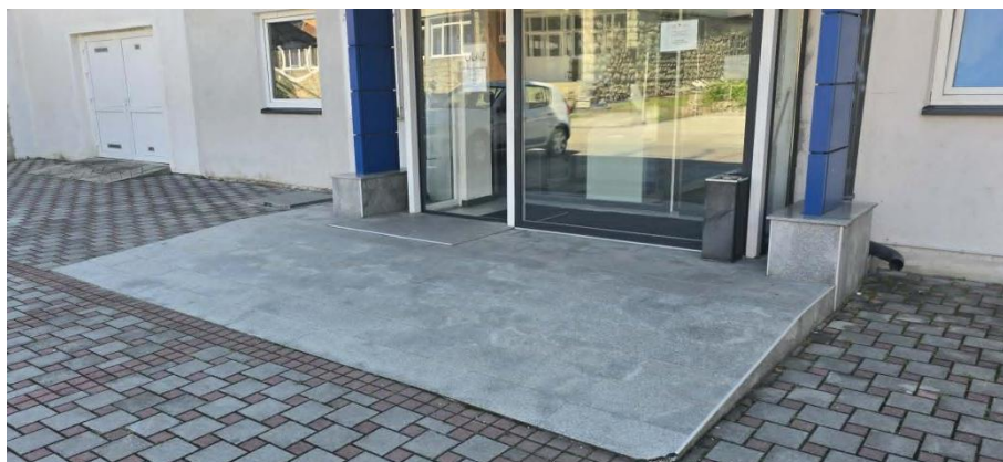
Slika 11. Pristupačan ulaz u objekat CIPS-a
