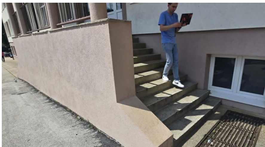
Slika 5. Pristup objektu Mašinske srednje škole
