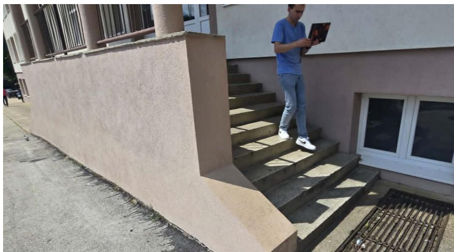
Slika 5. Pristup objektu Mašinske srednje škole
